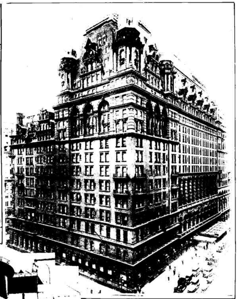
EL HOTEL WALDORF-ASTORIA, uno de los hoteles más famosos de New York, que será derribado rápidamente para construir en su lugar un edificio de 50 pisos, destinado a oficinas.
